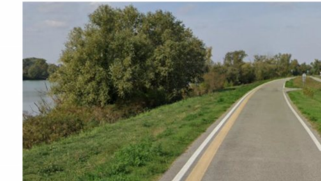
Foto 3 - A sinistra è individuabile il lato di aggr so cui verrà installato il diaframma, a destra la strada di sommità arginale.
